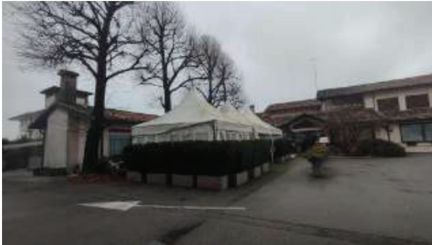
FOTO 1 : vista ingresso principale
