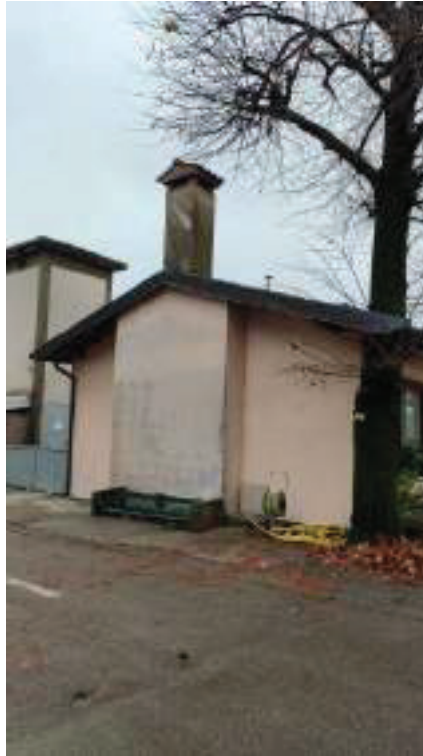
FOTO 3 : vista prospetto esterno lato sud-est
