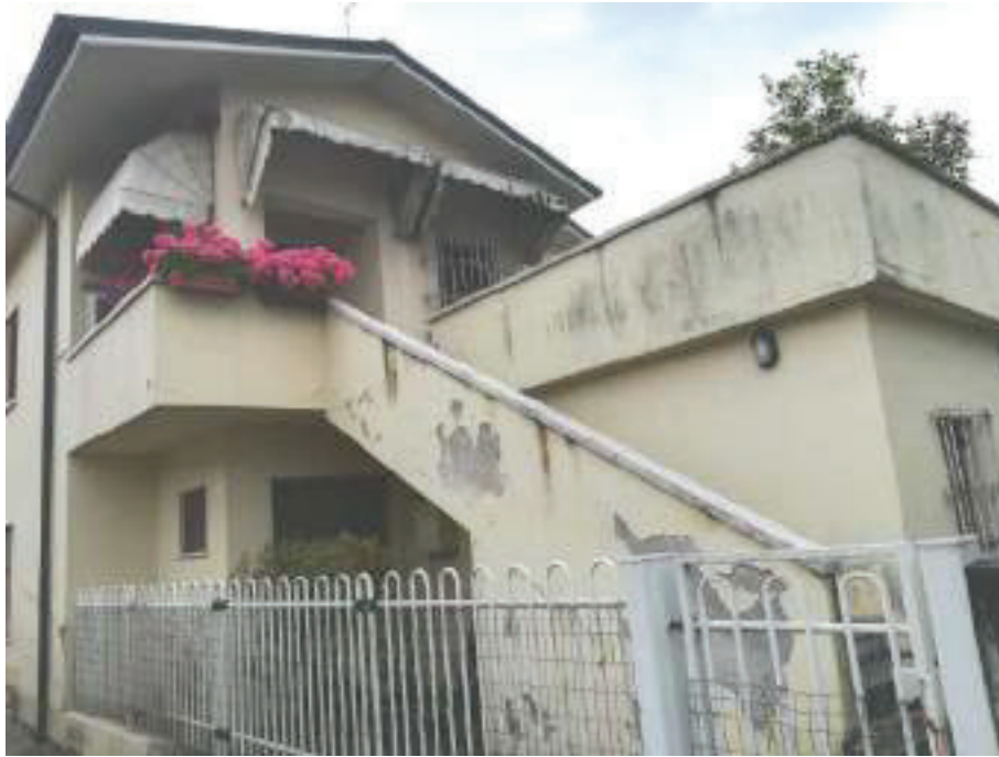
FOTO 1: vista prospetto esterno
