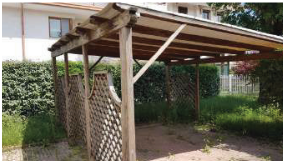
FOTO 2: vista prospetto esterno
