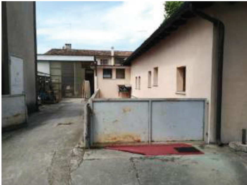
FOTO 4 : vista prospetto esterno lato sud-est
